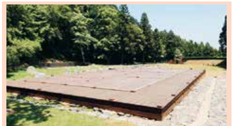
御主殿は復元的整備がされている
